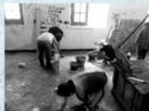
Curso de albañilería básica y elaboración de bloques año 2018 Centro MD1
